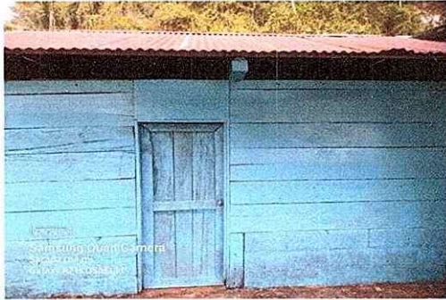
Foto 1: Cambio de Techo
