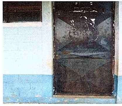
Foto 4: Pintada de puertas por deterioro de pintura.
