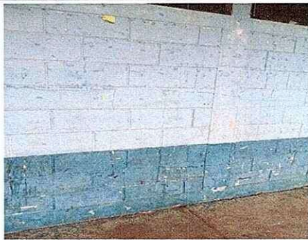
Foto 3: Pintura de paredes por deterioro.
