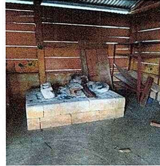
Foto 2: Rehabilitación de paredes.
